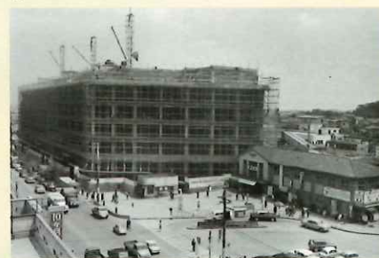
高島屋堺店 建設中
